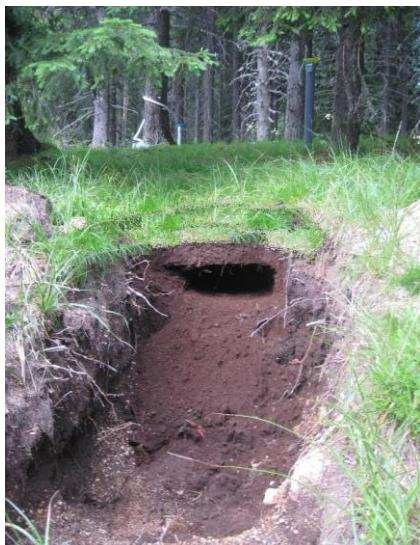
**Слика 43.** Припрема земљишног профил за инсталацију гравитационог лизиметра
