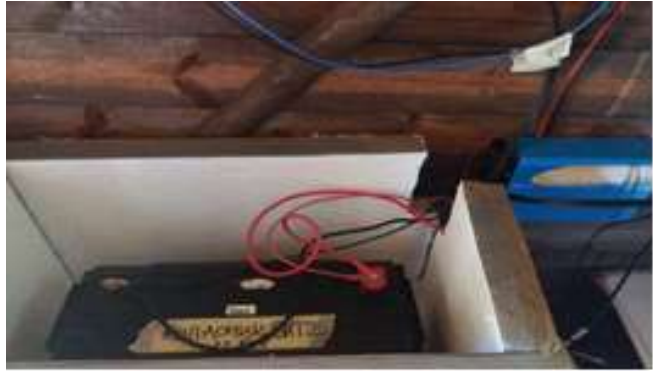
Слика 358. и 359. БИТ 2 Копаоник - Припремање и постављање акумулатора и прикључење конвертора соларног панела за снимање после зимске сезоне, април 2018.
