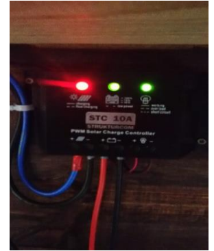
Слика 28. Контролни уређај довода напона струје са соларног панела Figure 28. The control unit of the solar panel power supply system
